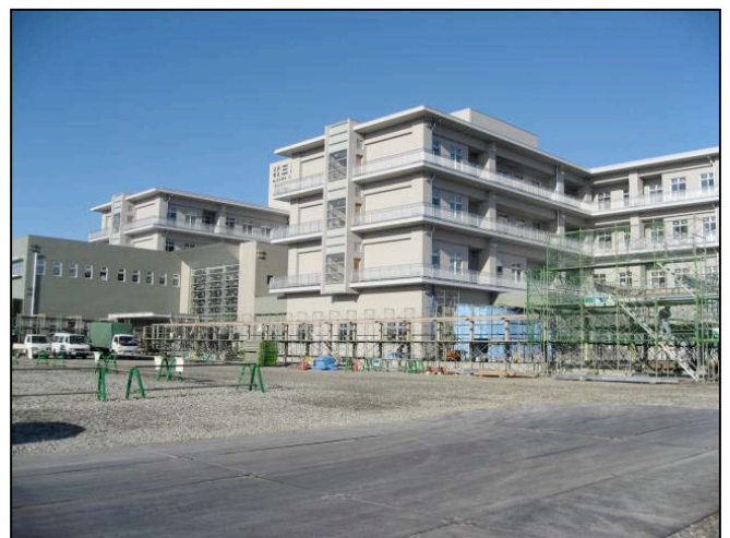
Ⓓ 各階 内外装施工中・外部足場撤去中
