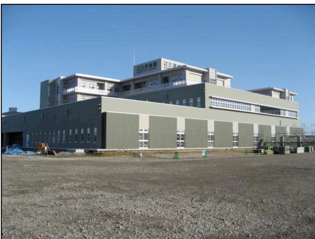
Ⓒ 各階 内装施工中
