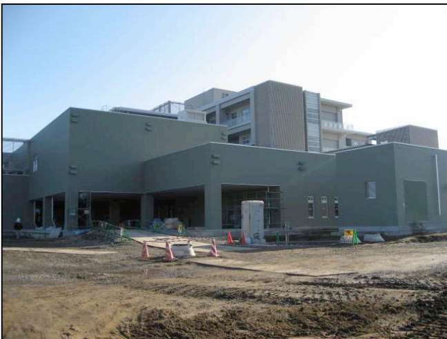
Ⓐ 各階 内装施工中
