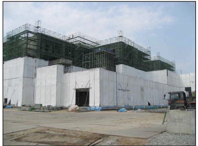
Ⓓ 防音サッシ等取付及び PH 階施工中
