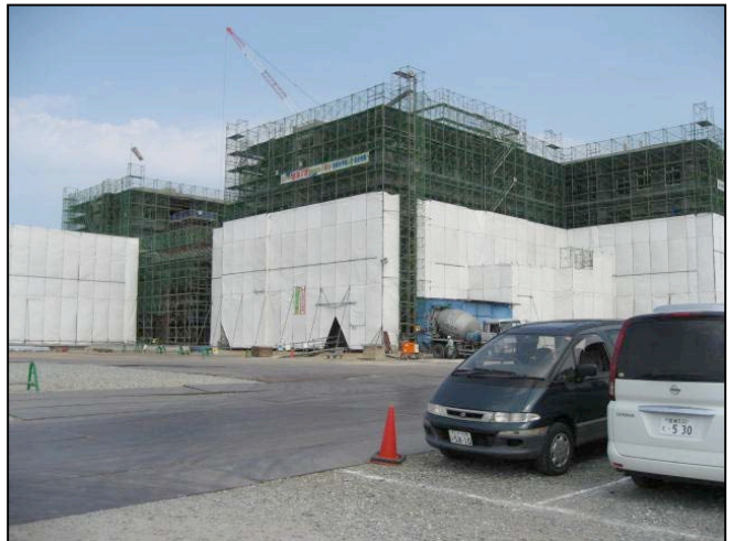
Ⓓ 防音サッシ等取付及び PH 階施工中
