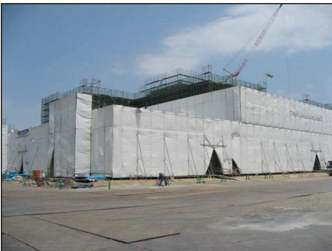
Ⓒ 防音サッシ等取付及び PH 階施工中
