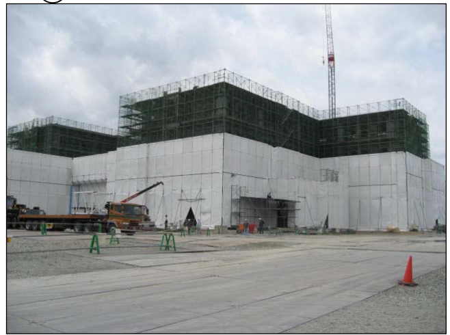
Ⓓ 3・4階柱・梁完了
