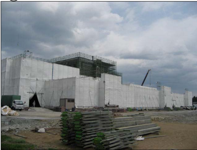
Ⓐ 3・4階柱・梁完了
