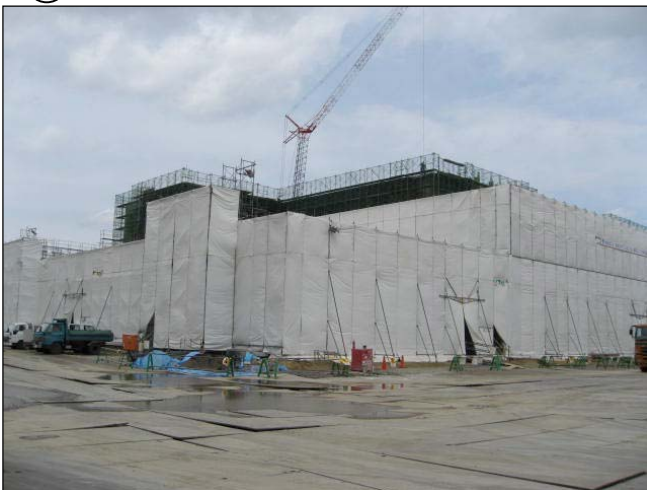
Ⓒ 3・4階柱・梁完了
