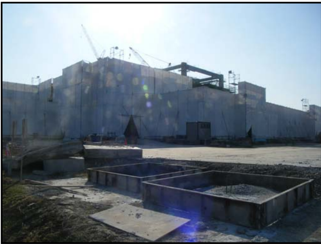
Ⓐ 3・4階柱・梁完了
