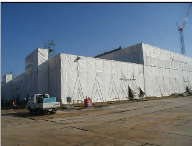
Ⓒ 3・4階柱・梁完了
