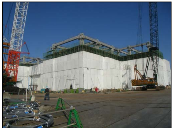
Ⓓ 3・4階柱・梁完了
