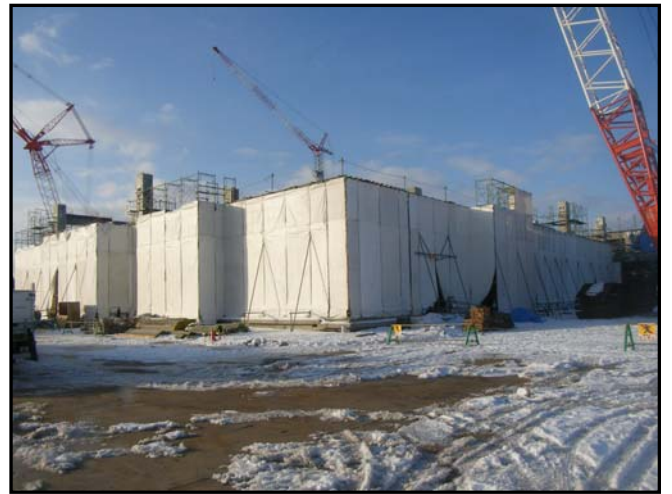
Ⓑ 1・2階柱建込・梁完了
