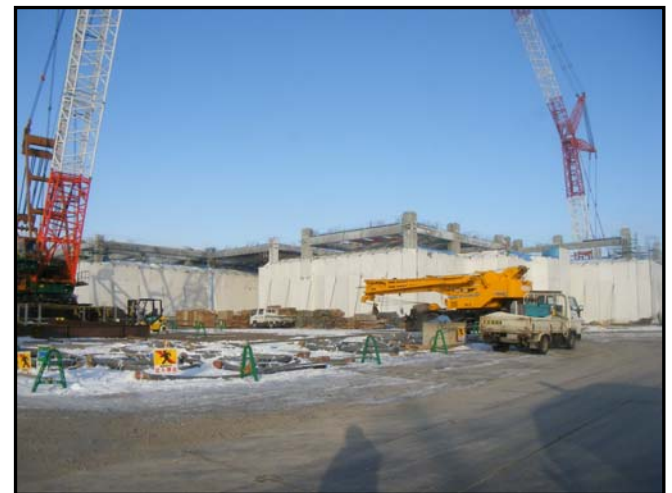
Ⓓ 1・2階柱建込・梁完了
