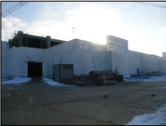
Ⓐ 1・2階柱建込・梁完了、
