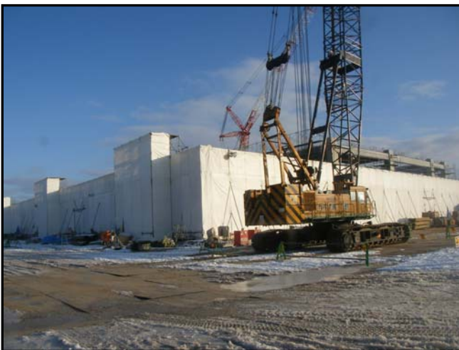
Ⓒ 1・2階柱建込・梁完了
