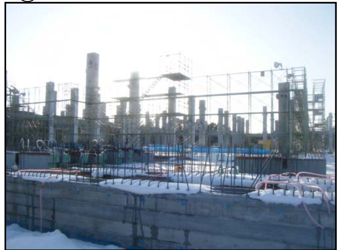
Ⓑ 1・2階柱建込完了
