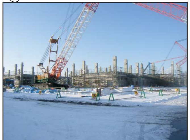
Ⓓ 1・2階柱建込完了、1階梁完了
