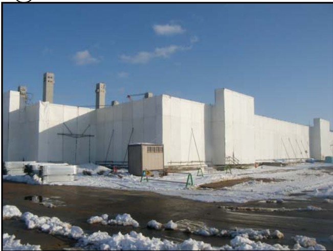
Ⓐ 1・2階柱建込完了、1階梁完了
