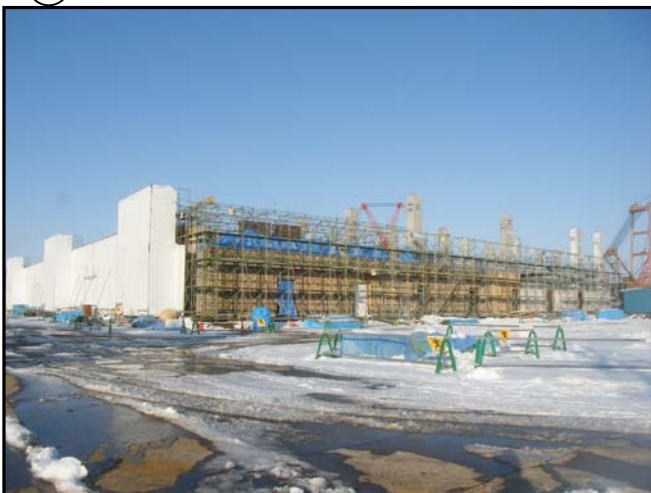
Ⓒ 1・2階柱建込完了、1階梁完了
