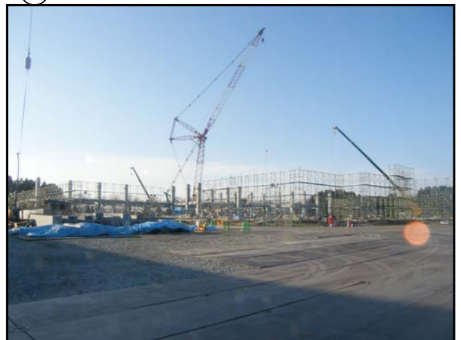
Ⓓ 1・2階柱・梁（施工中）
