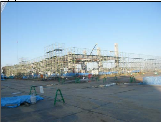
Ⓒ 1・2階柱・梁（施工中）
