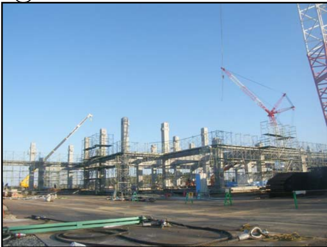
Ⓐ 1・2階柱・梁（施工中）
