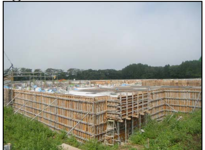
Ⓒ 地下免震部（免震装置施工中）
