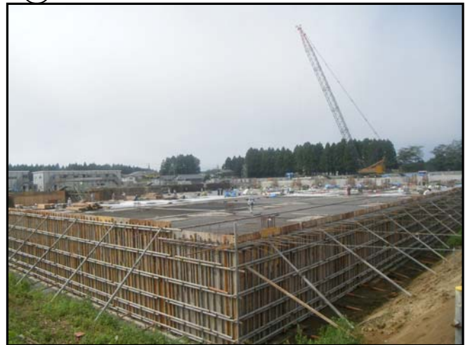
Ⓑ 地下免震部（免震装置施工中）
