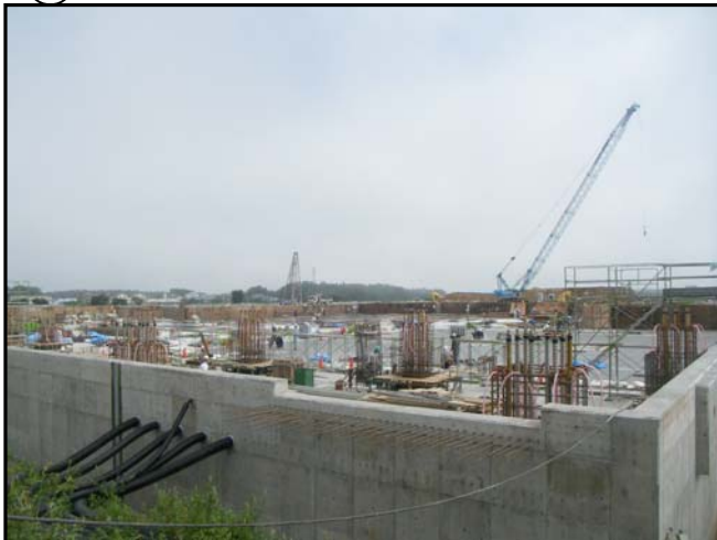
Ⓓ 地下免震部（免震装置施工中）
