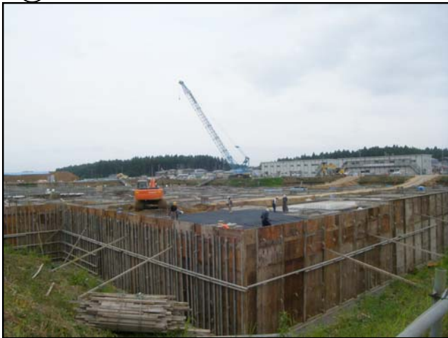
① 基礎工事
