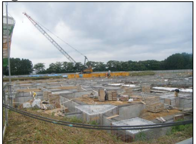
④ 基礎工事
