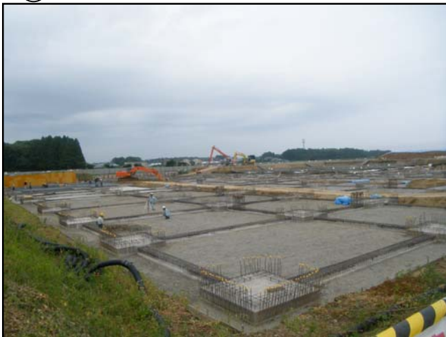
③ 基礎工事
